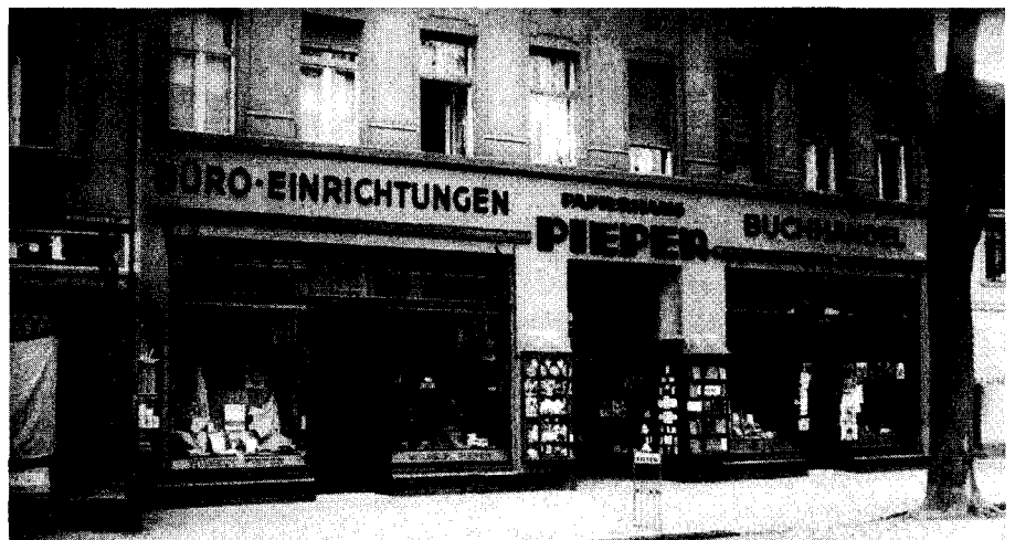
Ansicht des Geschäftshauses „Pieper“, Breite Straße 17. Im linken Laden war ab 1943 die Volksbücherei untergebracht.
