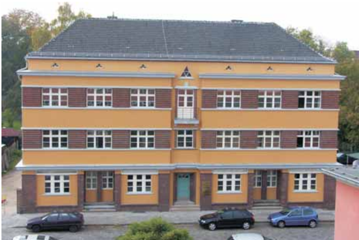
Sanierung Theaterstraße 16d
