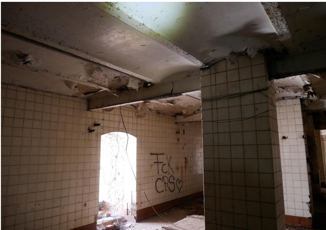
Abb. 9 Beispiel für Habitatstrukturen zwischen abstehender Farbschicht und Gebäudedecke in einem Gebäudebereich, der für Fledermäuse geeignet ist. (Foto G. Pelz)
