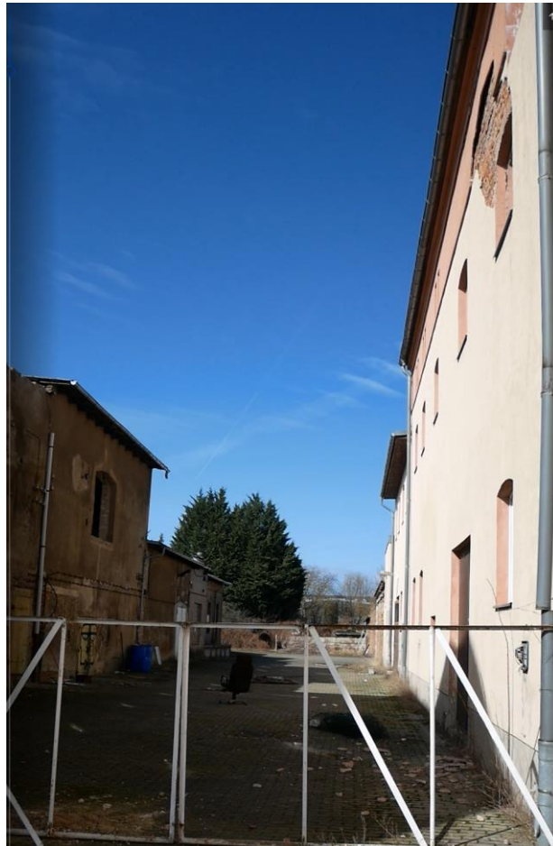
Abb.1 Zwei der zum Rückbau vorgesehene Gebäude in Luckenwalde Beelitzer Str.12 (Foto G. Pelz)
