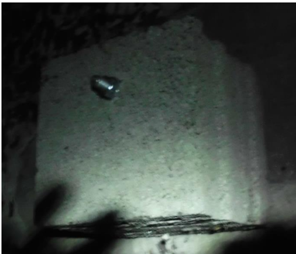
Abb.4 Fertig montierter Hohlblockstein, dessen Kammeröffnungen nach unten weisen (Foto G. Pelz)
