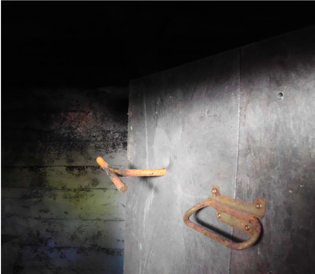
Abb.6 Geöffnete Luke aus Recyclingkunststoffplatten mit dem dazugehörigen Speziesschlüssel von außen. (Foto G. Pelz)
