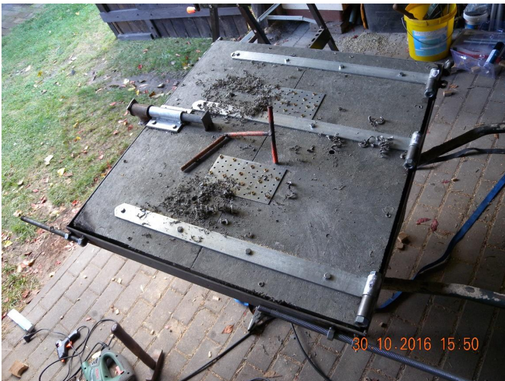
Abb.7 Die vorbereitete Luke mit Winkelrahmen und Riegel. (Foto G. Pelz)
