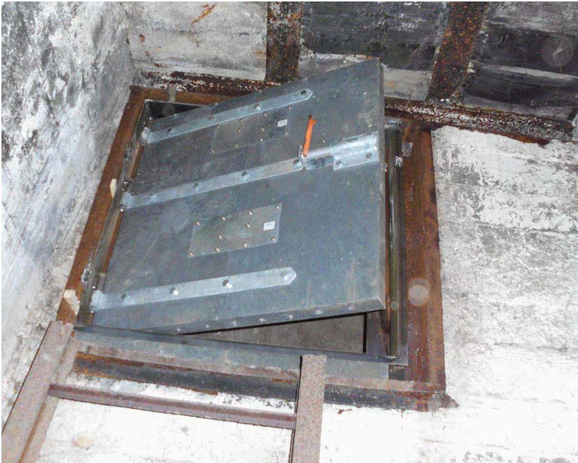
Abb.5 Beispiel einer geöffneten Luke aus Recyclingkunststoff von innen. (Foto G. Pelz)
