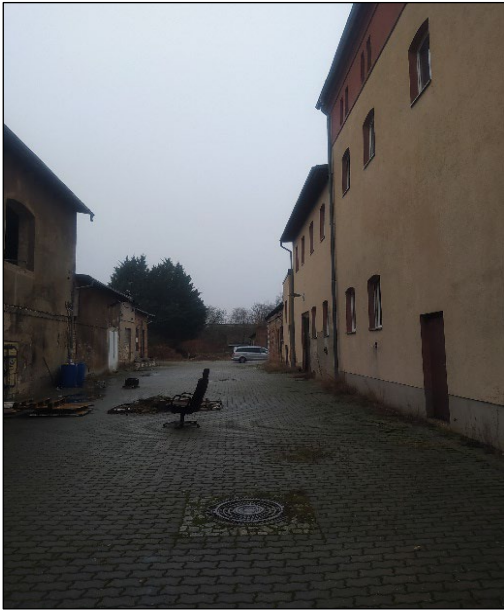
Abbildung 5: mittlere Zuwegung zwischen Gebäudebestand; Blickrichtung W
