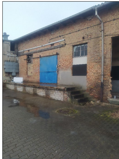
Abbildung 8: Bestandsruine im PG
