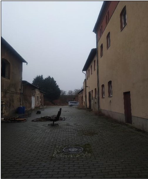
Abbildung 5: mittlere Zuwegung zwischen Gebäudebestand; Blickrichtung W
