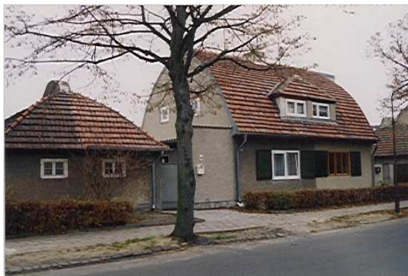
Spitzbogentonnendach (Bohlendach/Vollwalm)
