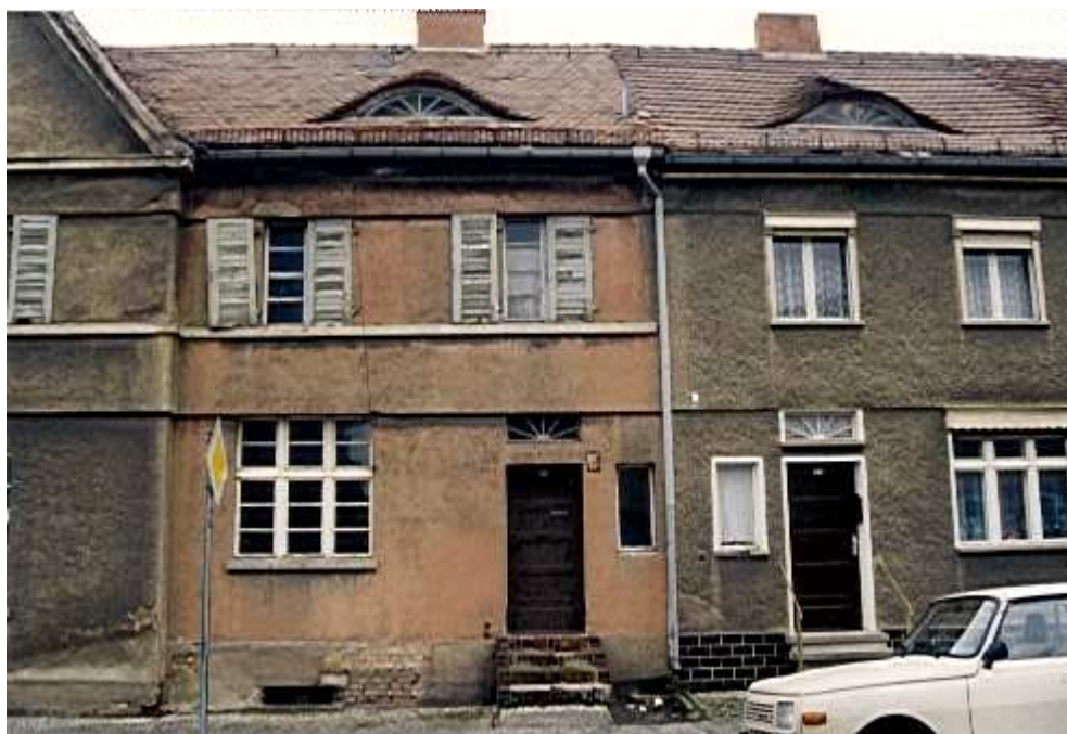
Originaler Zustand der Fenster, Fensterläden und Hauseingangstüren in der Rudolf Breitscheid Straße als Muster für Ersatzmaßnahmen
