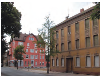
Rückbau in der Schützenstraße
