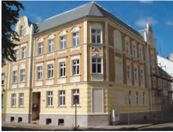
Modernisierung Dahmer Straße 35
