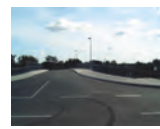
Fertiggestellter Bereich Schwindsuchtsbrücke
