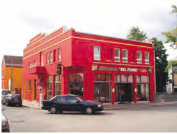
Sanierung und Modernisierung Breite Straße 21
