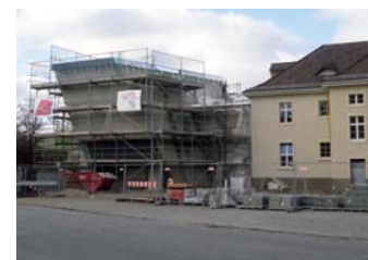
7 - Bahnhof verputzt, Beginn der Verkleidung der Kinder- und Jugendbibliothek Oktober 2007
