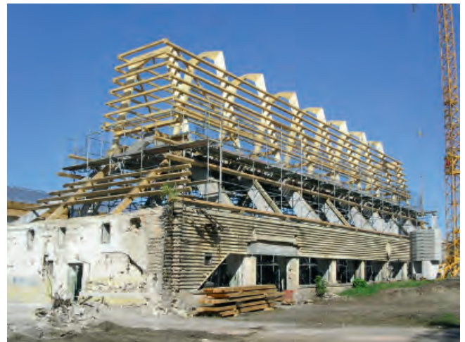
Herstellung des „Hutes“ aus Holz-Leimbändern anstelle der 1935 entfernten Stahlbeton-Rahmenbinder, 2006
