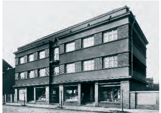
Das Katasteramt kurz nach der Fertigstellung
