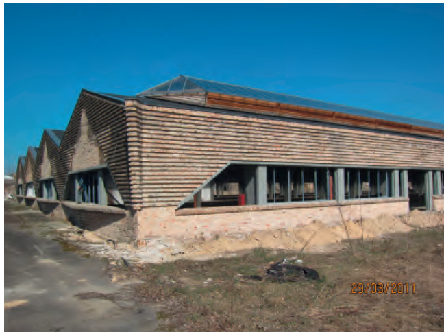
Außenansicht der Halle im März 2011
