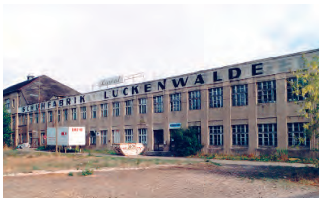
Ansicht der ehemaligen Pianofortefabrik Niendorf von der Rudolf-Breitscheid-Straße aus
