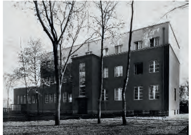
Ansicht von der Lindenstraße, 1929
