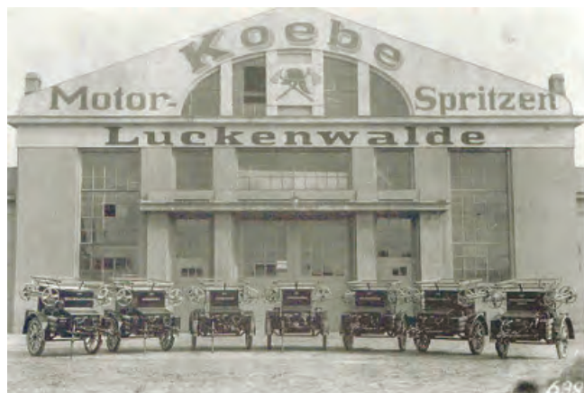
Frontalansicht der Fabrikhalle nach der Fertigstellung
