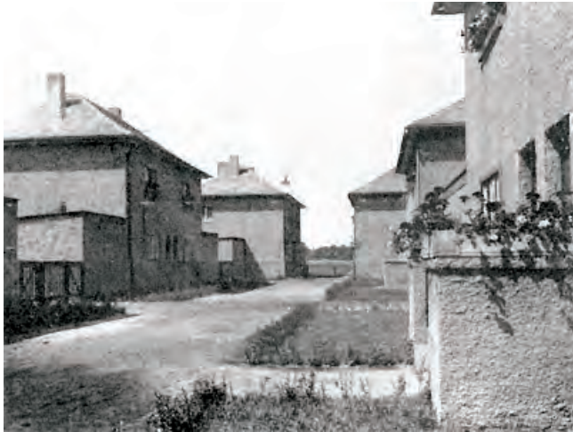
Blick in den Upstallweg kurz nach Fertigstellung der Bebauung
