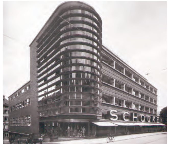
Kaufhaus Schocken in Stuttgart, 1926–28 (Foto: R. Bothner)
