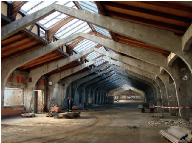
Sanierte Stahlbeton-Rahmenträger, Dach und Oberlichter, geschlossener Fußboden, Dez. 2006
