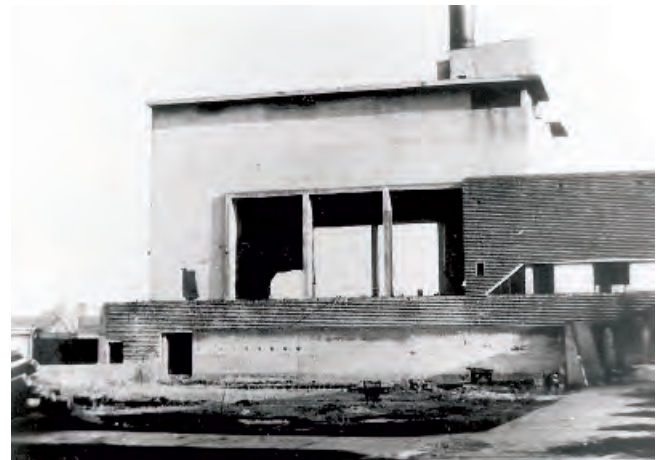
Kesselhaus während des Umbaus von 1957
