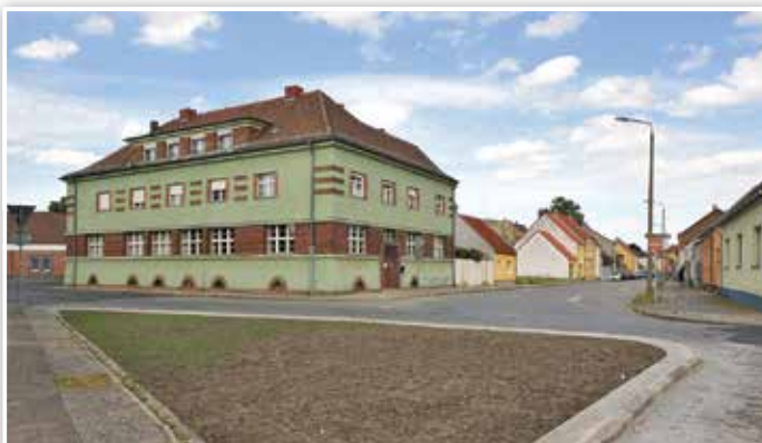
Bäume und Sträucher fehlen noch – die neugestaltete Kreuzung Auguststraße, Kirchstraße.
