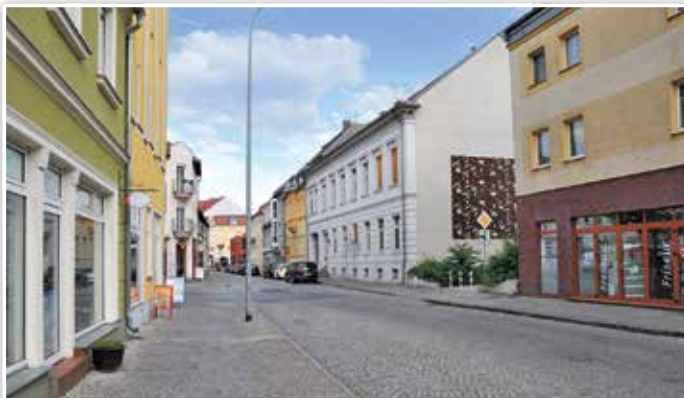
Vor der Straßenlaterne wird hier eine Einbuchtung in die Fahrbahn entstehen, um die Stelle für Fußgänger sicherer zu machen.
