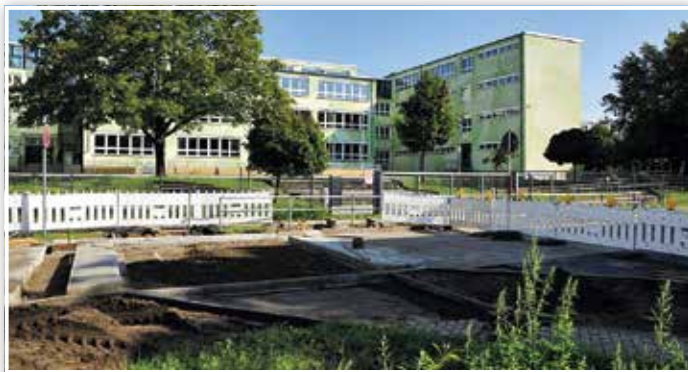
Baustand Mitte August vor der Jahnschule
