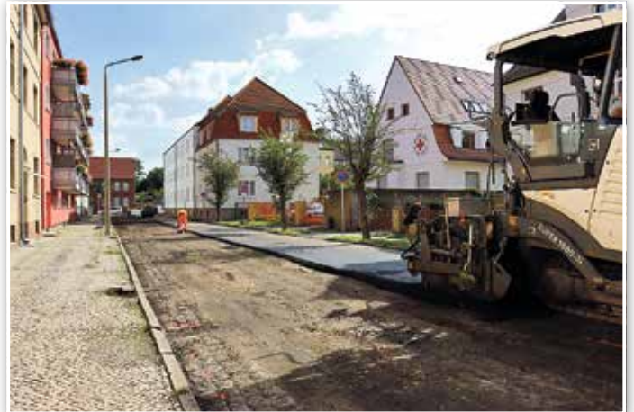
In nur wenigen Tagen erhielt die Fahrbahn eine neue Deckschicht.
