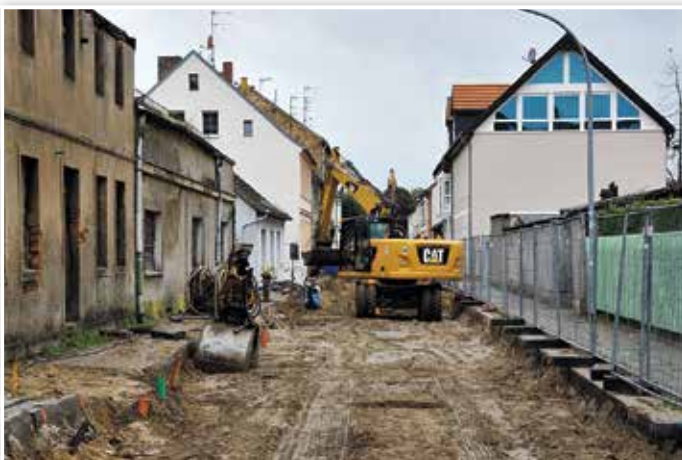
Derzeit wird die Luckenwalder Buchtstraße saniert.
