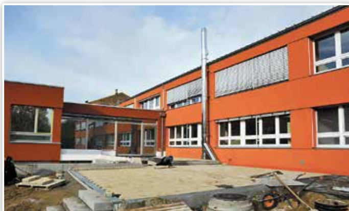
Der Anbau schließt sich nahtlos an das Bestandsgebäude (rechts) an.
