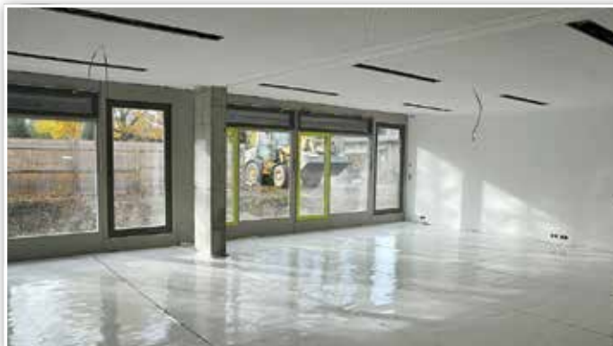
Die Fußböden sind bereits fertig und wurden zum Schutz mit einer Folie abgedeckt.
