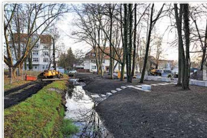
Auf der Baustelle Ehrenhain wurden Ende November Löcher in den Boden gerammt. Schwere Gerät rückte an, um Vertiefungen links und rechts des Röhregrabens in den Boden zu treiben. Dort entstehen die Widerlager, die ab nächstes Jahr eine Fußgängerbrücke tragen werden. Außerdem sind die neuen Wege und Treppen der Freifläche bereits zu erkennen. Steinplatten
