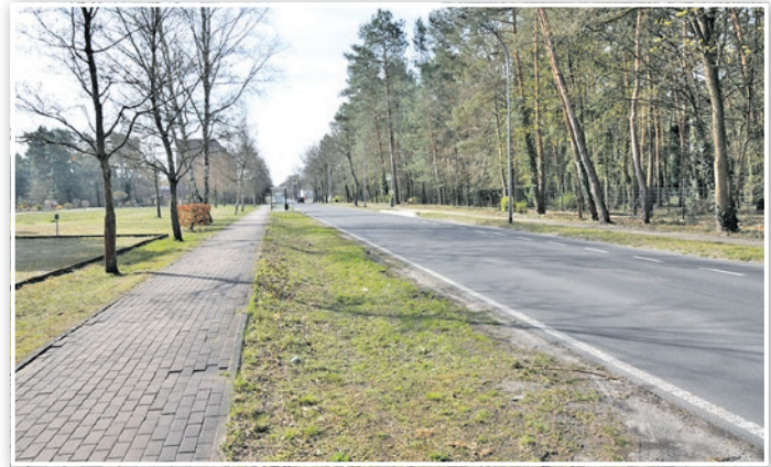
In den Versickerungsmulden in der Straße des Friedens ist das Parken verboten.
