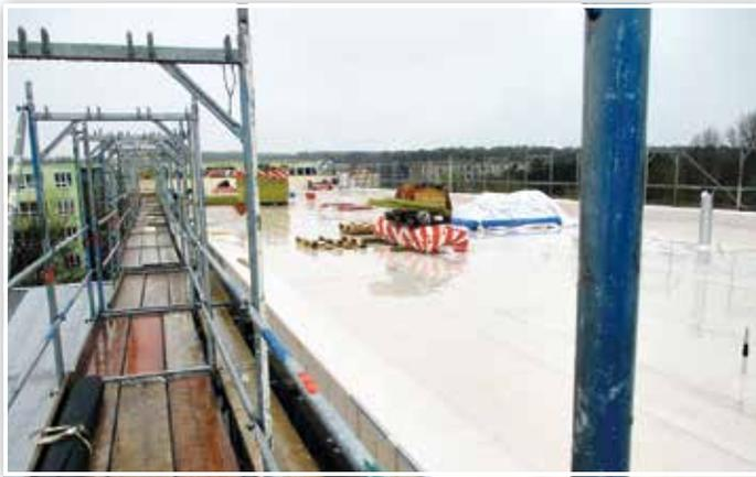
Der Hortneubau in der Ludwig-Jahn-Straße kommt gut voran. Inzwischen sind fast alle der zum Teil riesigen Fenster eingebaut. Im Inneren werden die Elektrik verlegt und Vorbereitungen für den Estricheinbau getroffen, bevor es dann mit der Fußbodenheizung und den Sanitäranlagen losgehen kann. Von unten unbemerkt machen auch die Dachdecker große Fortschritte.
