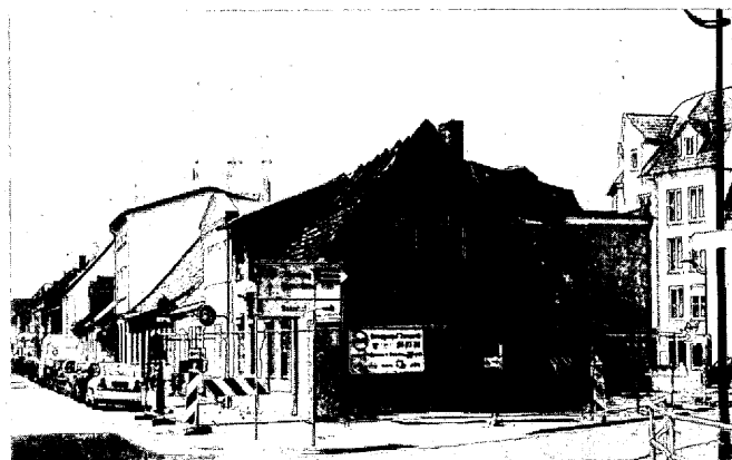
Gegenwärtig erfolgt der Abriss des Gebäudes. Die entstehende Freifläche wird mit „Kunst im öffentlichen Raum“ gestaltet.
